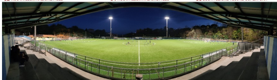
01 CAMPO CALCIO IN ERBA ARTIFICIALE 02 NUOVA ILLUMINAZIONE A LED 03 CAMPO TENNIS IN RESINA 04 NUOVA ILLUMINAZIONE A LED 05 RIQUALIFICAZIONE CENTRALI TERMICHE 06 SOSTITUZIONE TELONE COPERTURA
