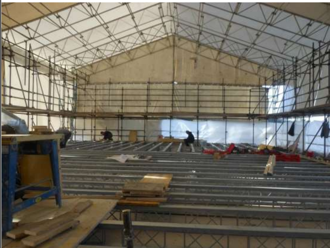
Ermitage Hotel - Éze Cantiere
