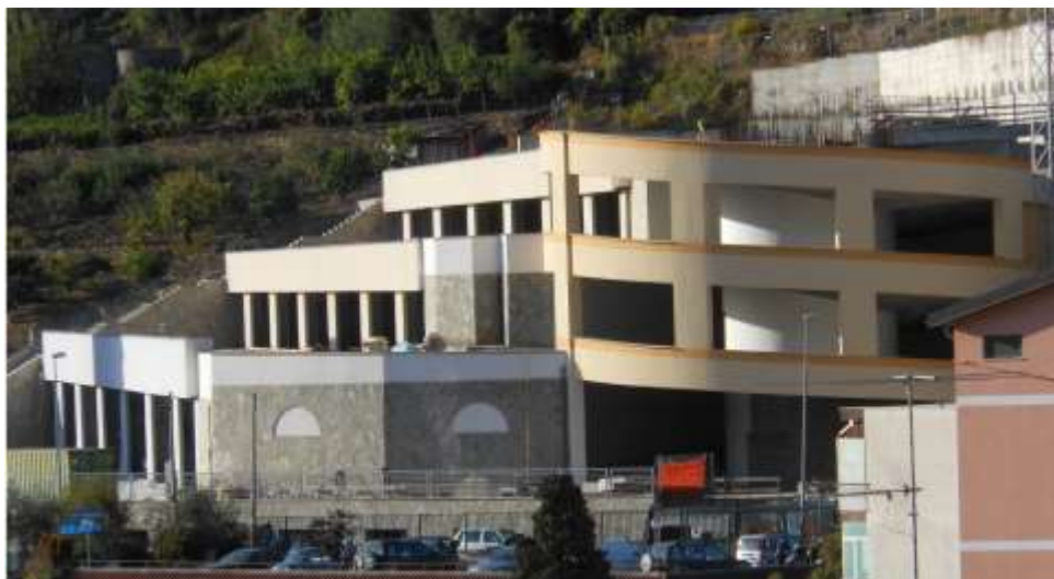
Fabbricato in corso di realizzazione – strutture completate.
