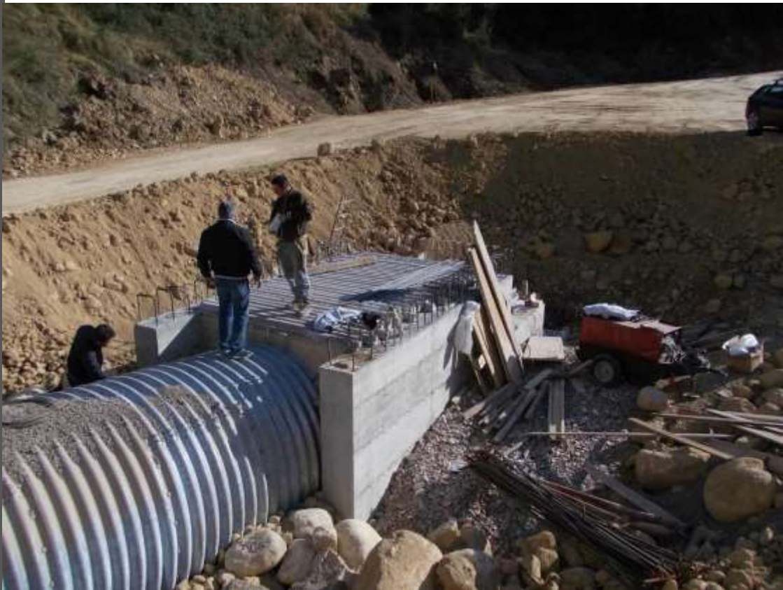
Fasi di cantiere
