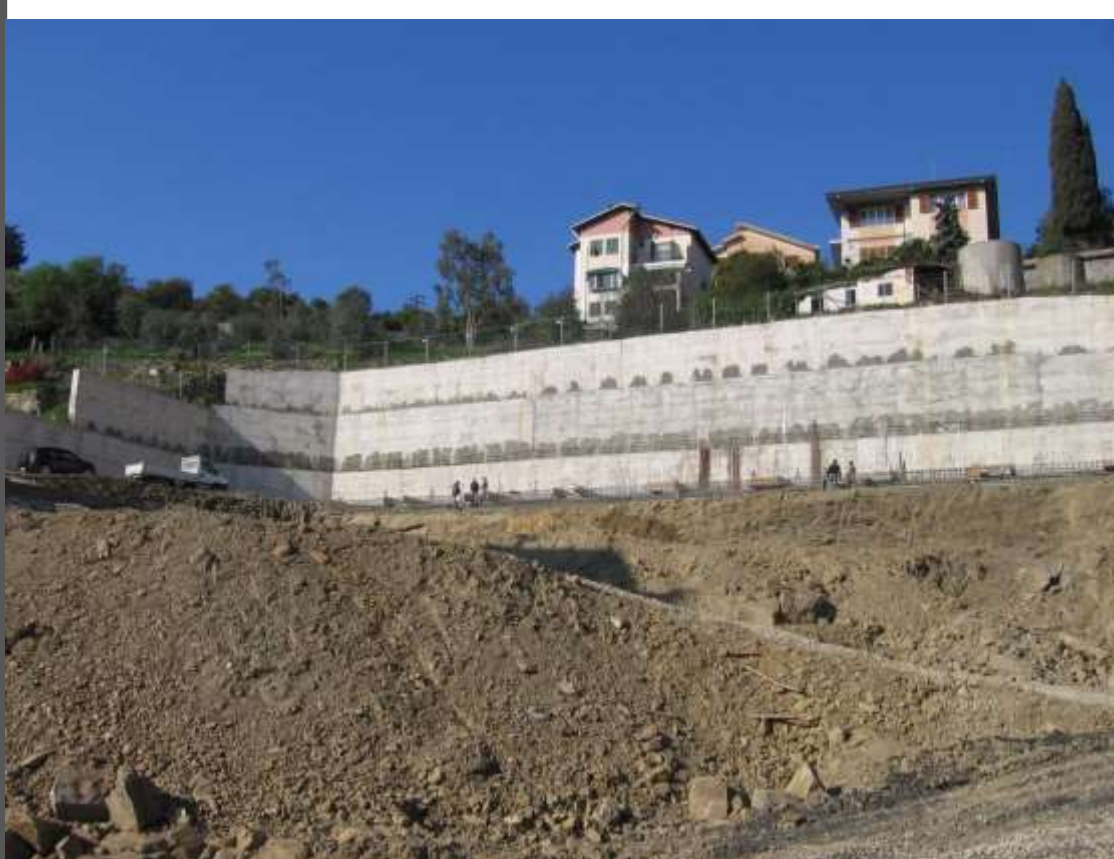
Fase di cantiere: realizzazione di opere di sostegno dello scavo generale realizzate con berlinesi di micropali rivestite in cemento armato
