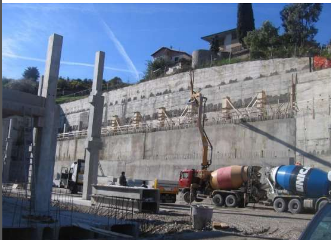
Fase di cantiere: completamento del primo livello delle opere di sostegno, realizzare con berlinesi di micropali rivestite in cemento armato
