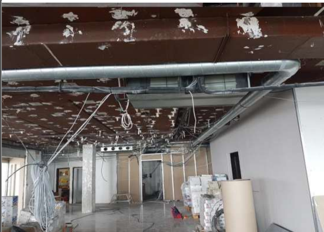
Les Terrasses d'Éze Fasi di cantiere
