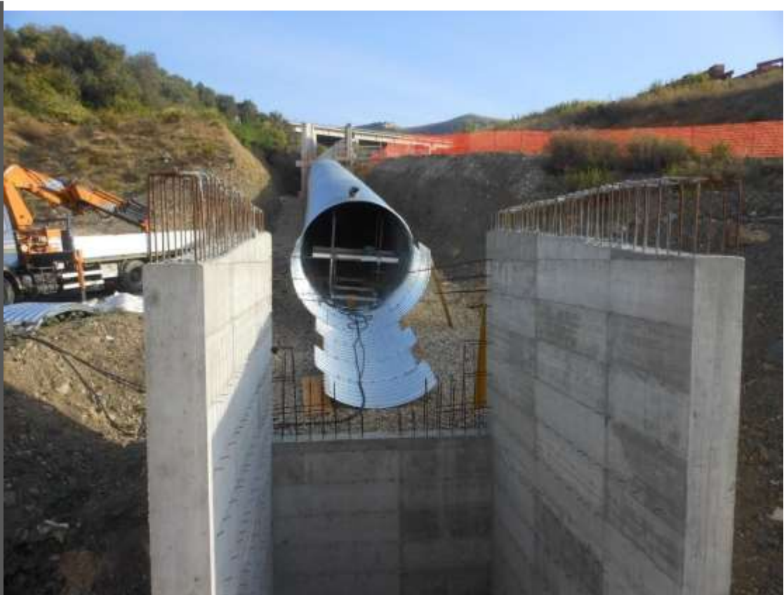
Fasi di cantiere
