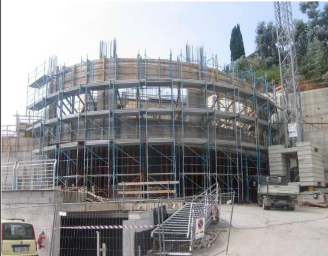
Fase di cantiere: costruzione rampa elicoidale
