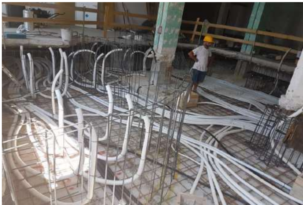
Les Terrasses d'Éze fase di cantiere piscina SPA
