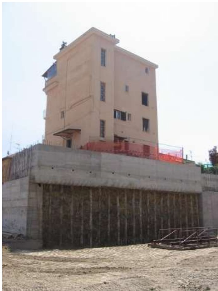
Fase di cantiere: messa in sicurezza della palazzina confinante con berlinese a sbalzo rivestita con parete in cemento armato
