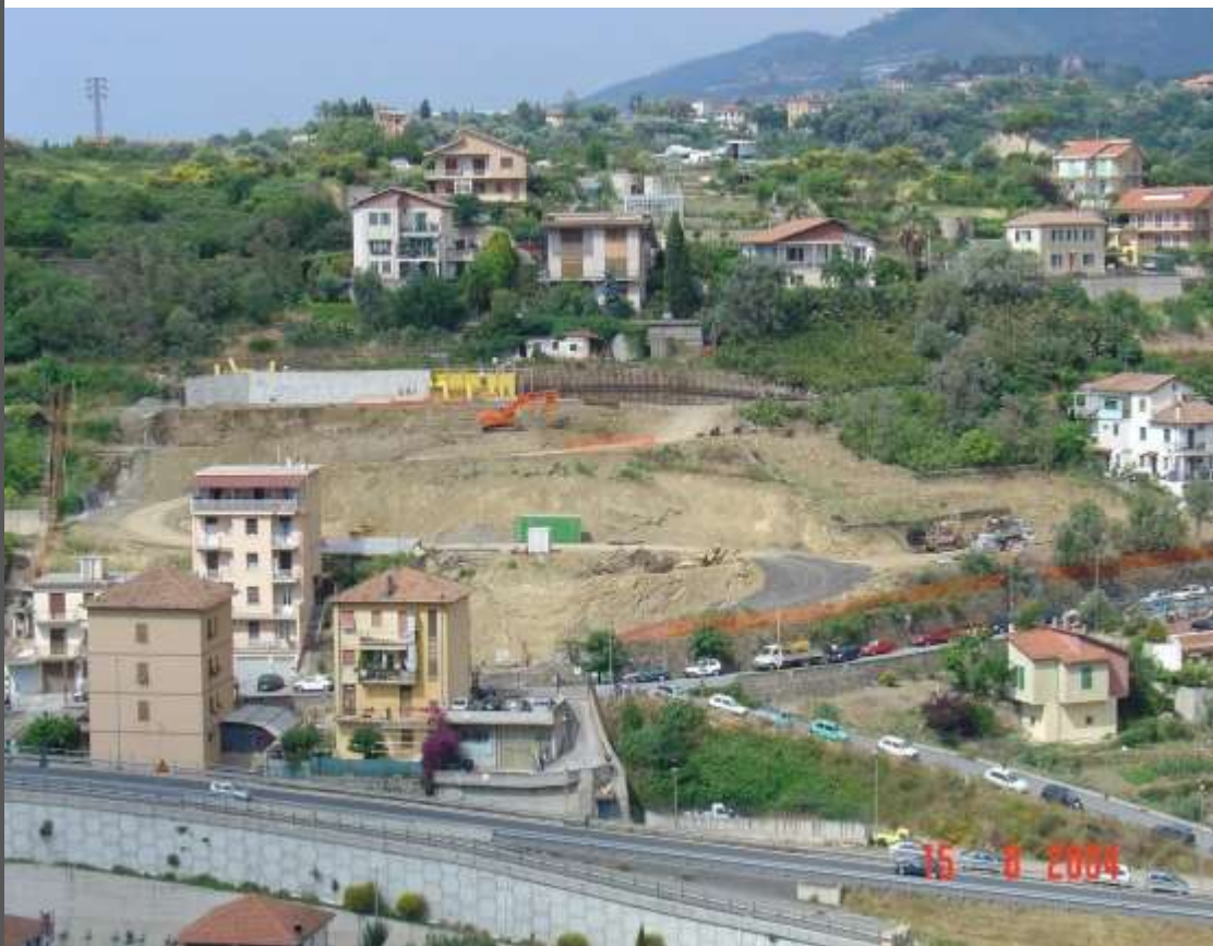
Fase di cantiere: inizio scavo del versante
