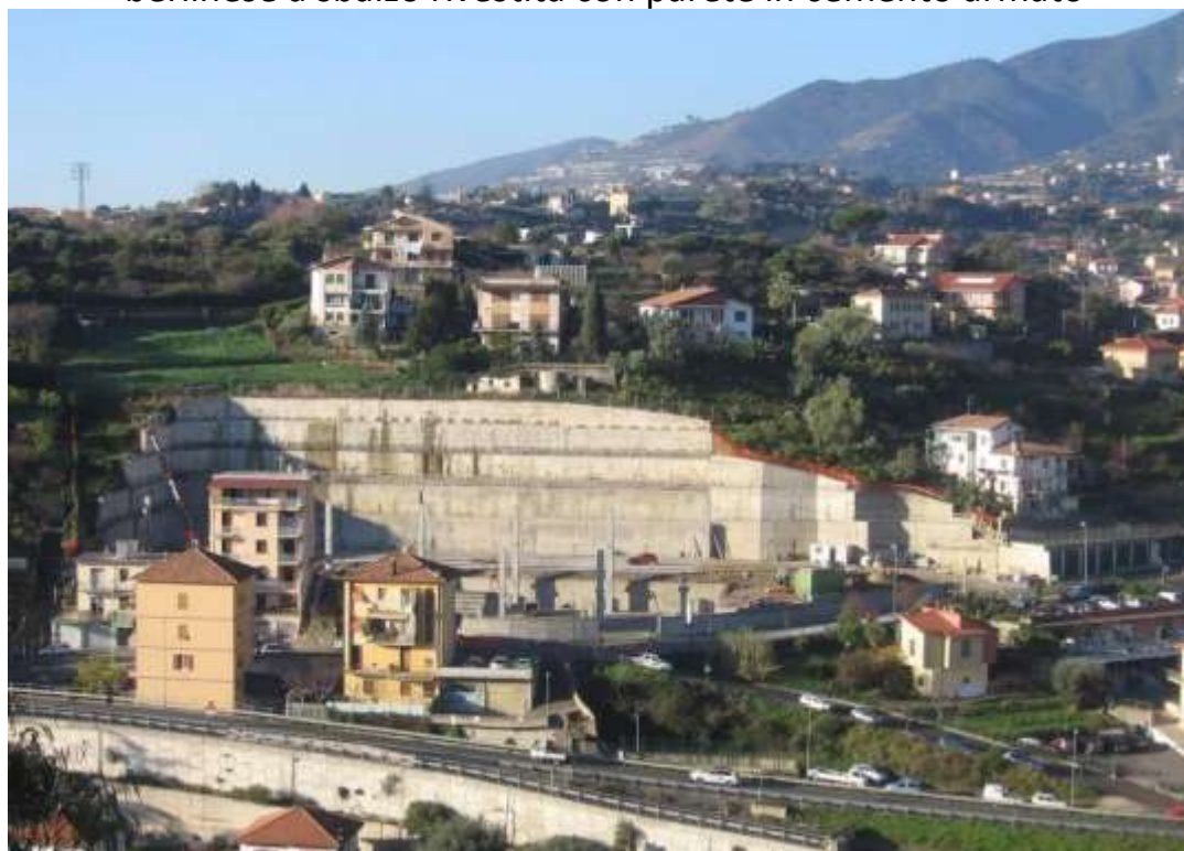
Fase di cantiere: messa in sicurezza della palazzina confinante con berlinese a sbalzo rivestita con parete in cemento armato
