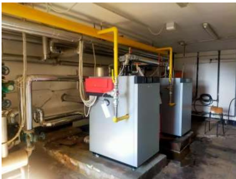
Stato finale dei lavori - CT Liceo Cassini Sanremo. Potenza termica installata 520Kw
