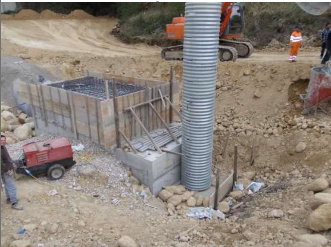
Fasi di cantiere
