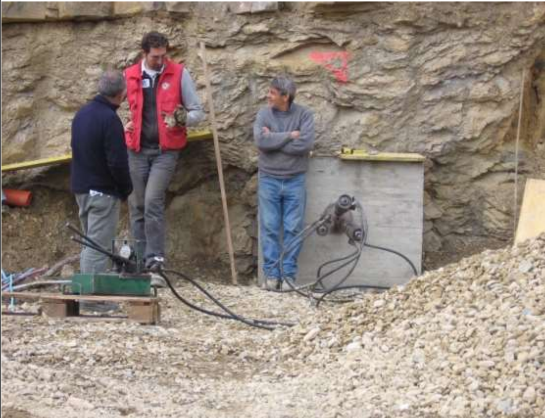
Fase di cantiere: prove di verifica alla tenuta dei tiranti
