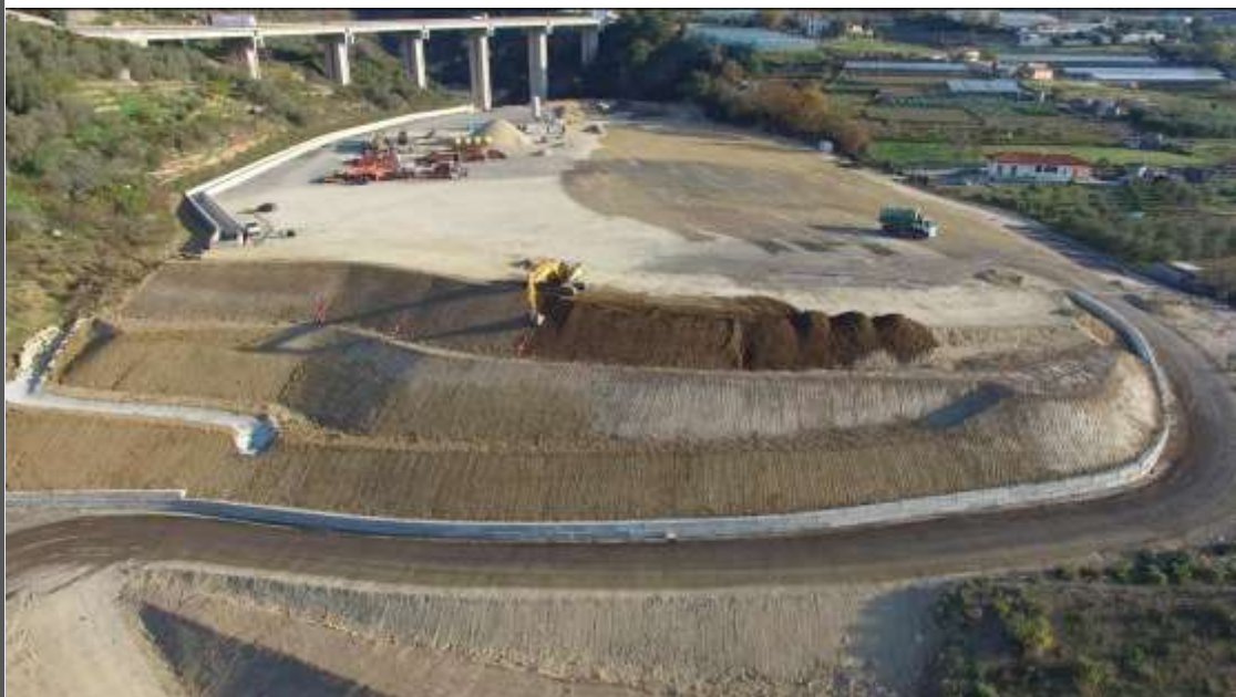
Progetto generale, strutturale e direzione lavori. Messa in sicurezza idrogeologica vallone Cascine, area ex Trasca - Cantiere 60.000 mq
