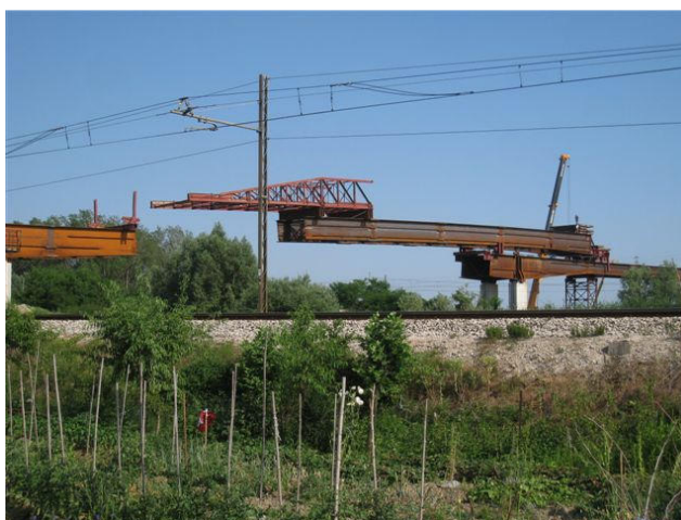
(fase al termine dell'avanzamento, prima del montaggio della puntina dell'avambecco)
