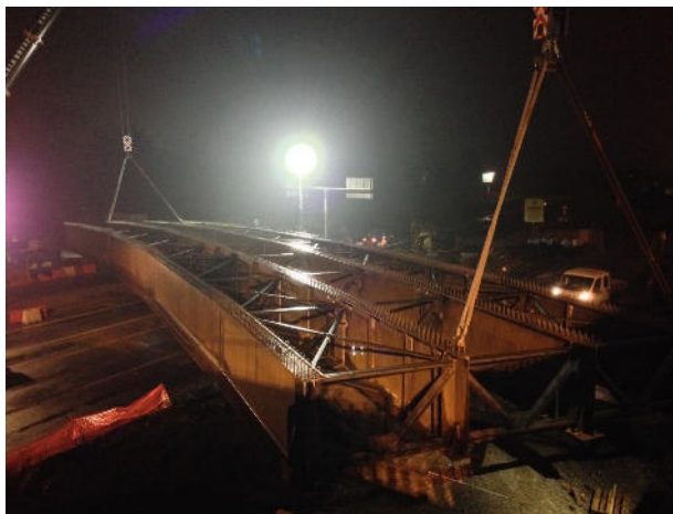
(VIL02 in fase di posa)
