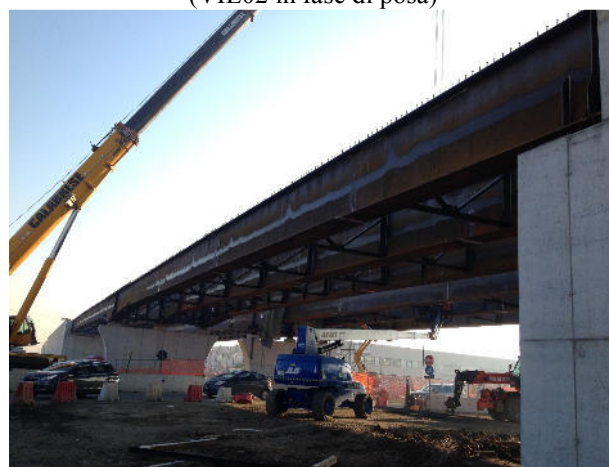
(VIL03 ad ultimazione assiembaggio carpenteria metallica)
