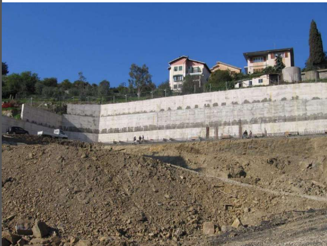
Sito fase edificazione strutture
