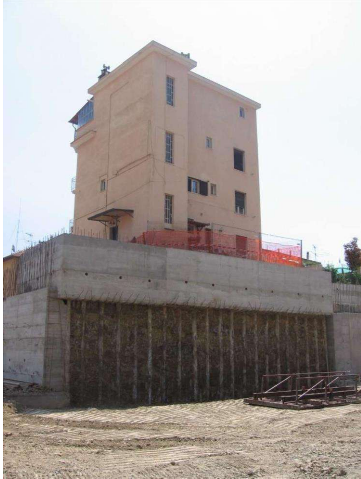
Sito fase edificazione strutture
