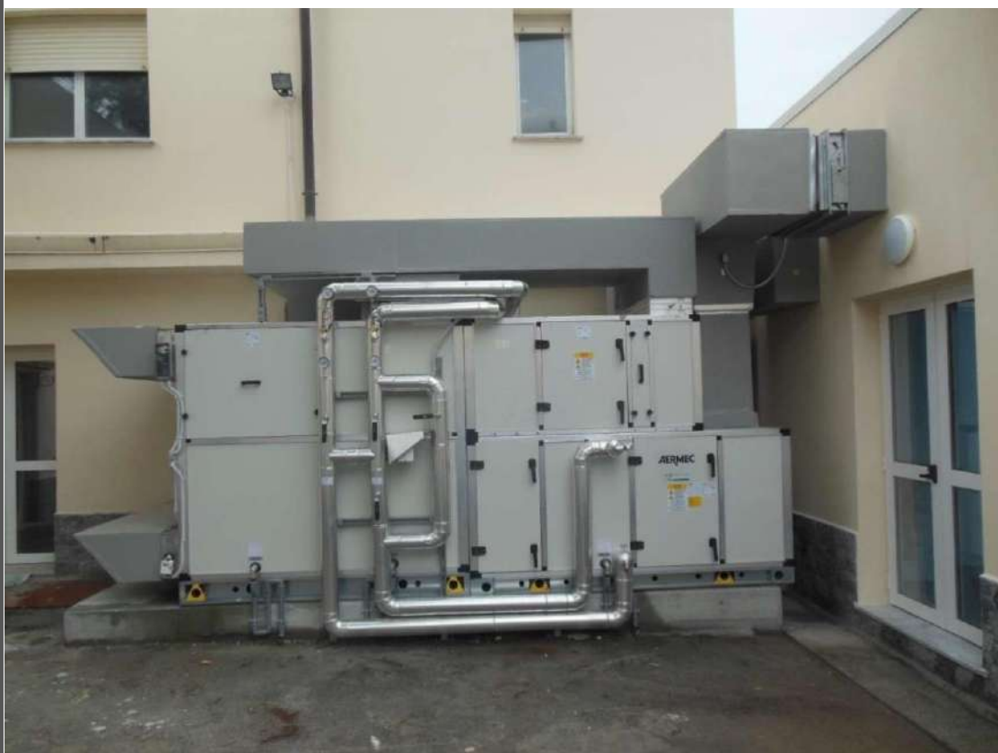
Fase finale: Unità di trattamento aria e unità di condizionamento
