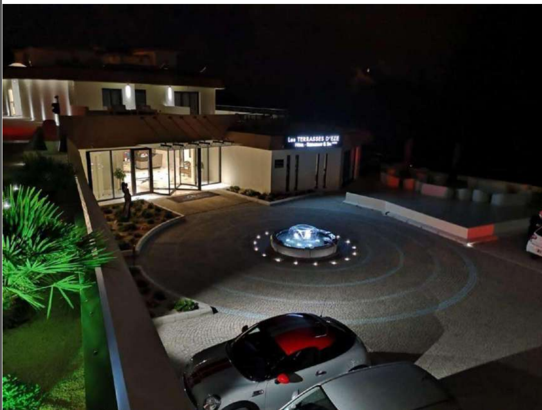
Lavori di rinnovo Les Terrasses d'Éze Hotel 9000 mq – Fase finale
