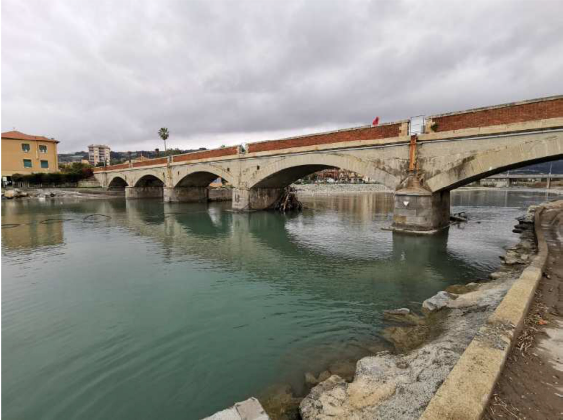
Vista del ponte esistente da valle
