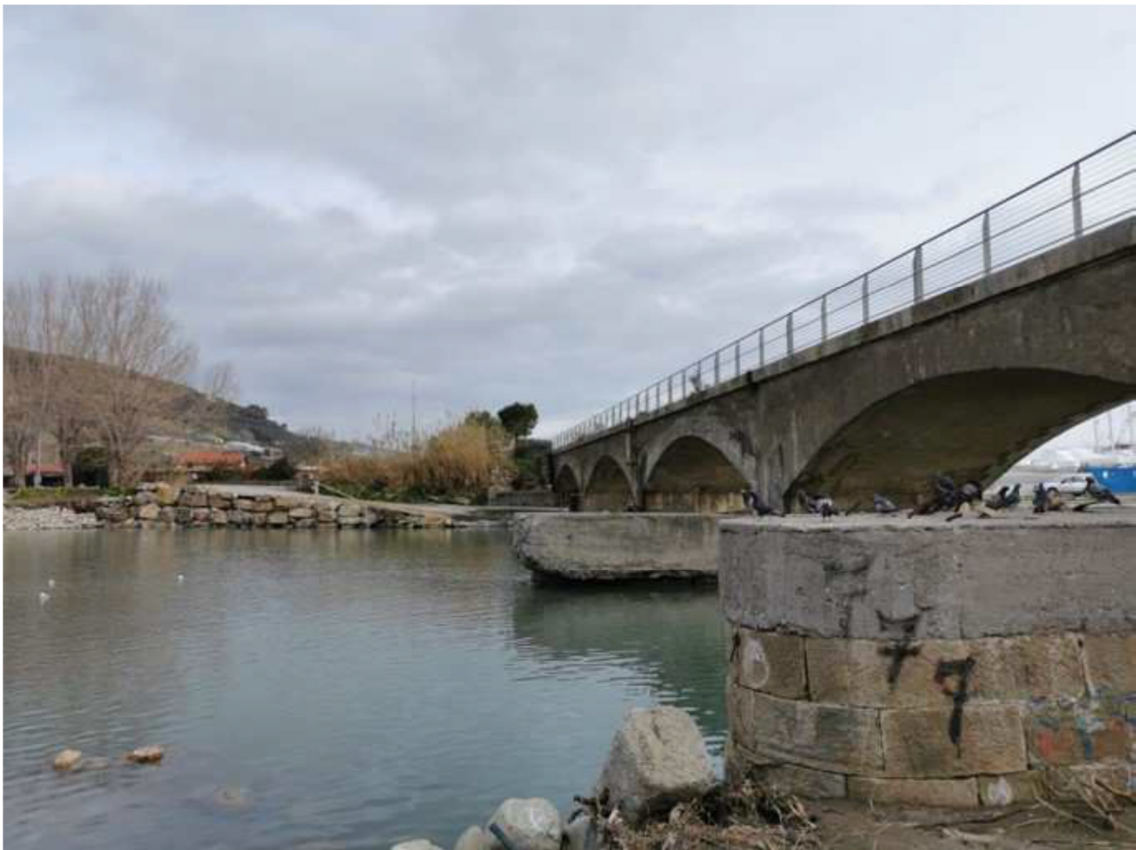
Dettaglio pile in alveo
