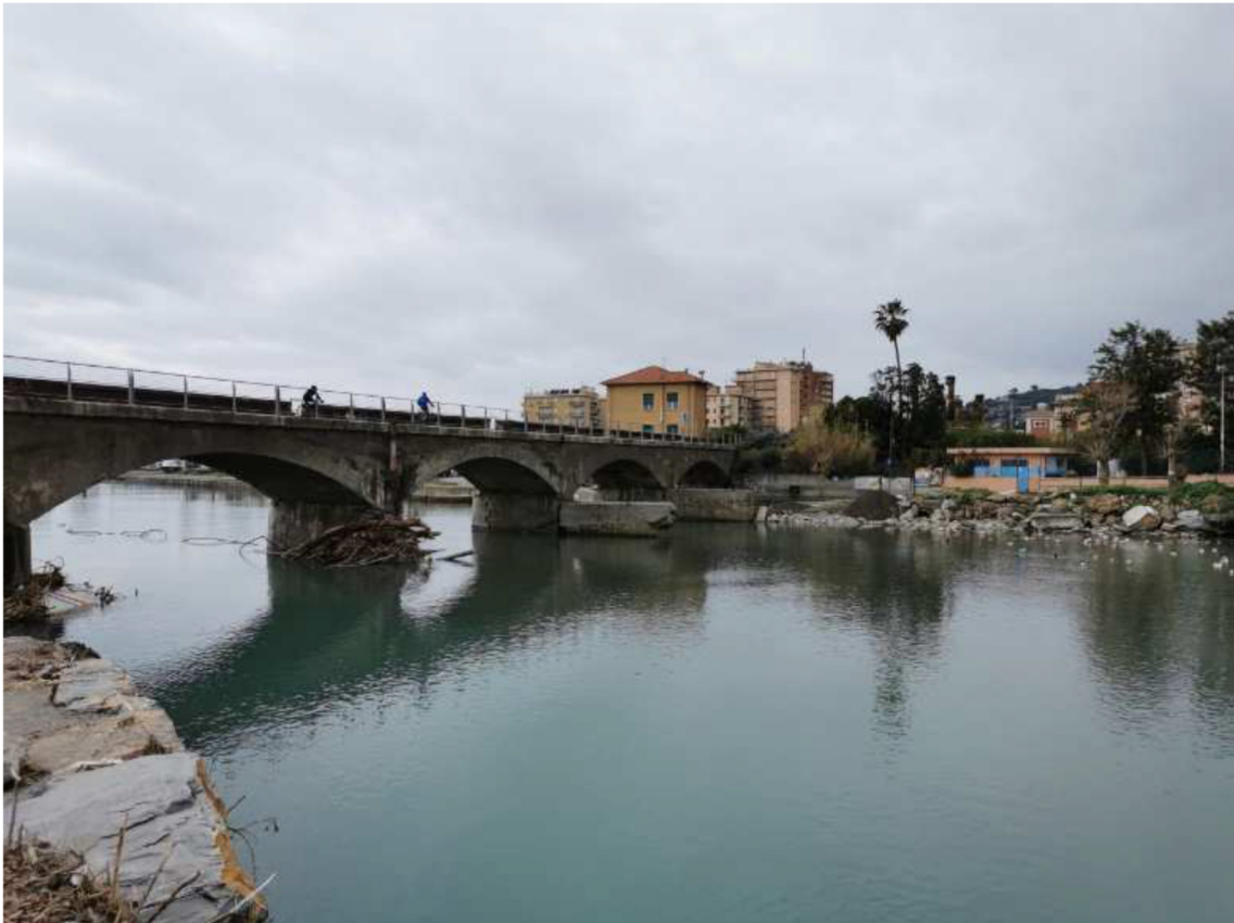
Ponte ciclabile ex FS, vista da monte
