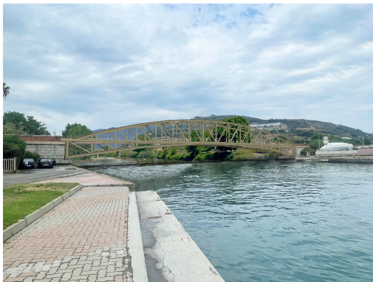
Situazione post intervento
