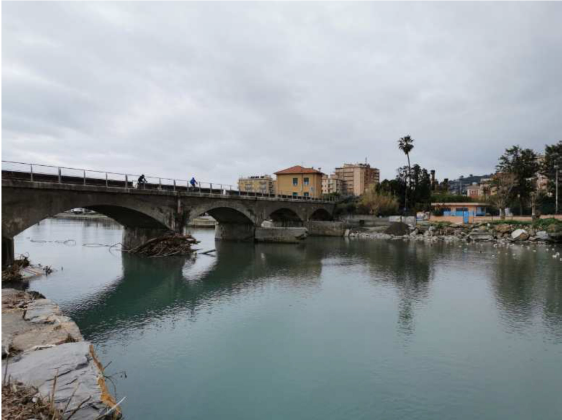
Ponte ciclabile ex FS, vista da monte
